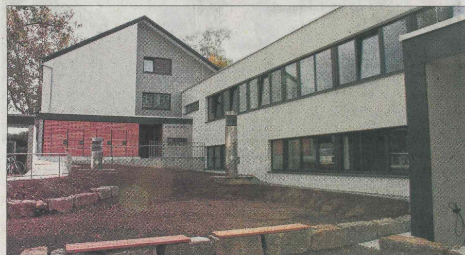
Zwischen dem neuen Wohnheim (im Hintergrund) und dem modernisierten Lehrgebäude muss nur noch der Rasen eingesät werden.
